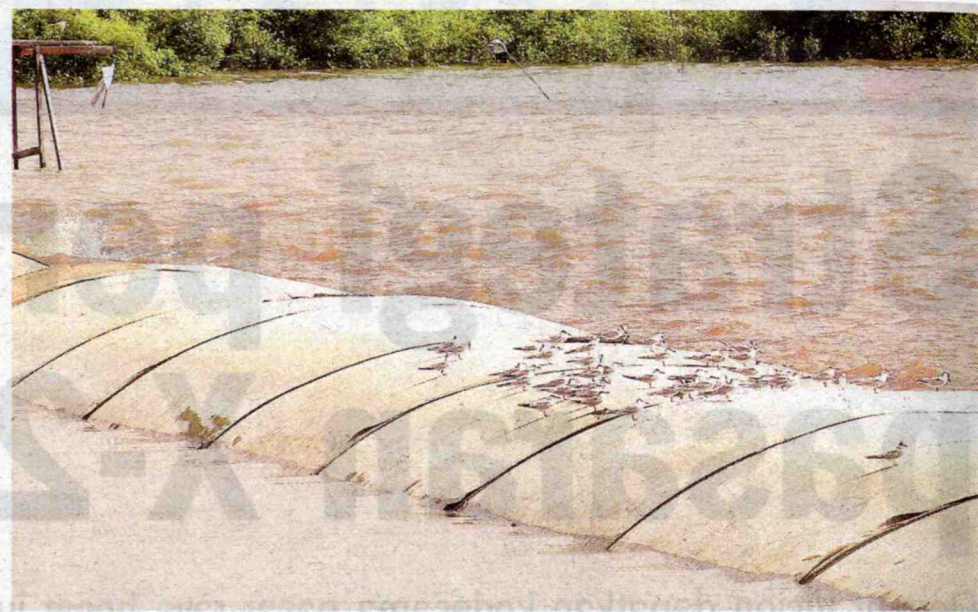
BERKESAN...tiub bantal digunakan untuk memulihara kawasan pantai.
