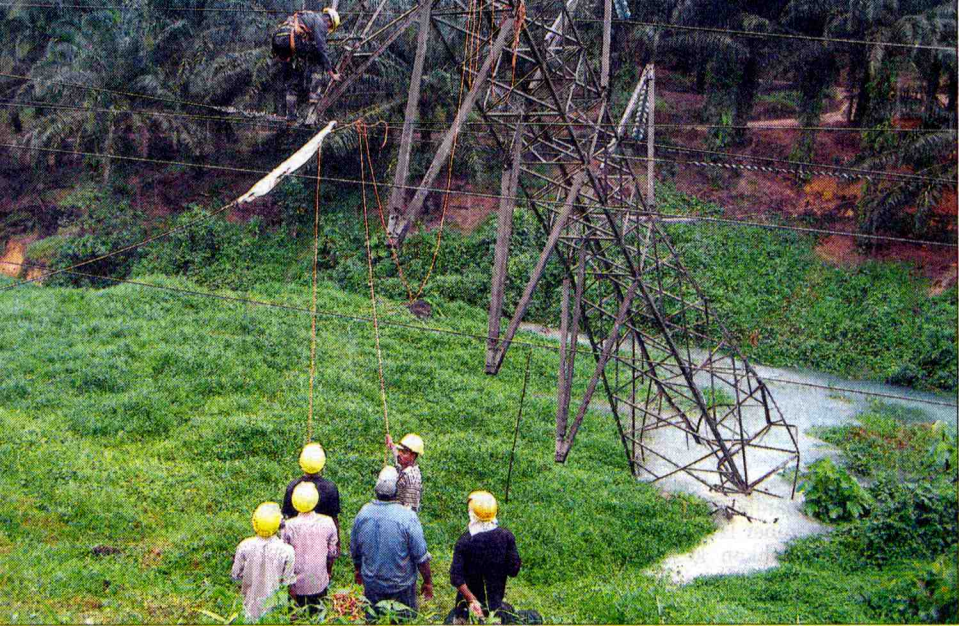
PETUGAS Tenaga Nasional Berhad (TNB) sibuk memperbaiki menara pencawang yang tumbang akibat gelongsoran tanah di Ulu Tiram semalam.
