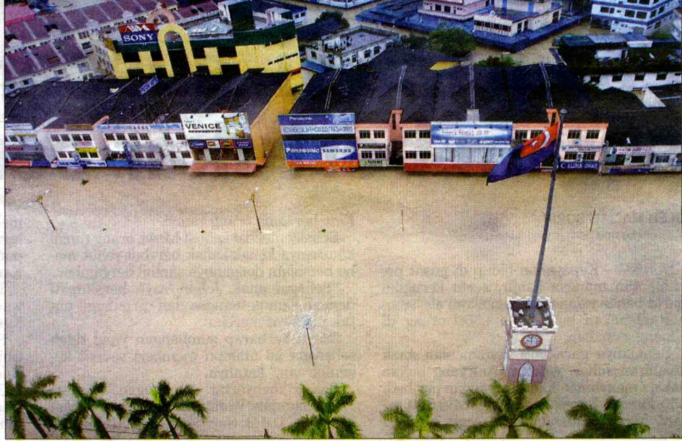
MERCU tanda bandar Kota Tinggi turut ditenggelami air yang naik mencecah bumbung tingkat bawah bangunan semalam.
