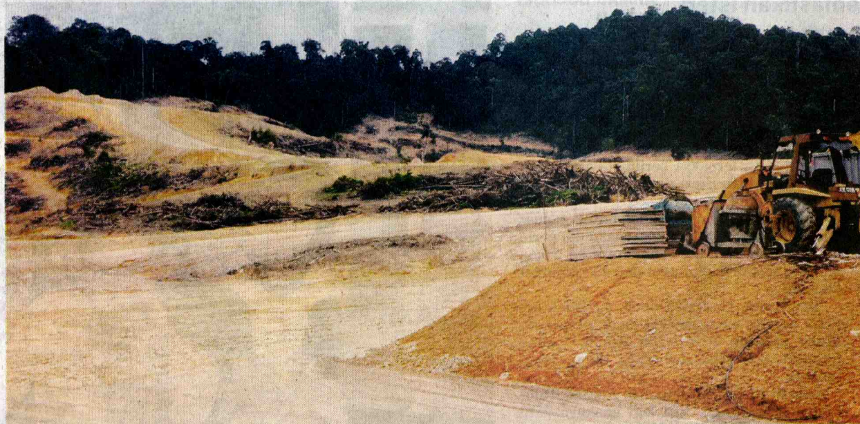
KERJA-kerja merata tanah di kawasan seluas 75 ekar milik Permodalan Negeri Selangor Berhad dihentikan bagi menunggu penilaian Jabatan Alam Sekitar dan Jabatan Pengairan dan Saliran ke atas pembinaan kolam tadahan di kawasan projek pembangunan hartanah di Mukim Bukit Raja, Seksyen U 10, Daerah Petaling, semalam.
