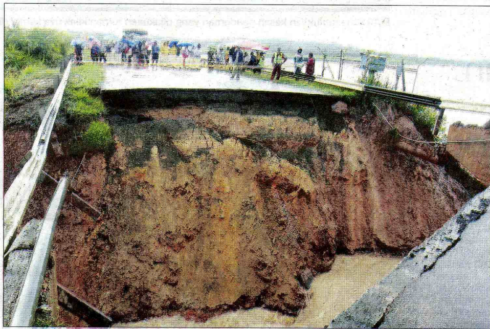
SEBUAH jambatan di Sungai Pekin dekat Felda Selancar, Rompin runtuh akibat arus deras ekoran hujan lebat semalam.
