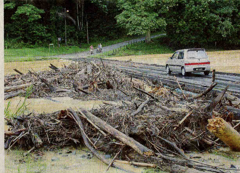
PERANGKAP MAUT: Sisa balak dan kayu yang terperangkap di Jambatan Sungai Lembing, Kuantan mengancam keselamatan pemandu di laluan itu.
