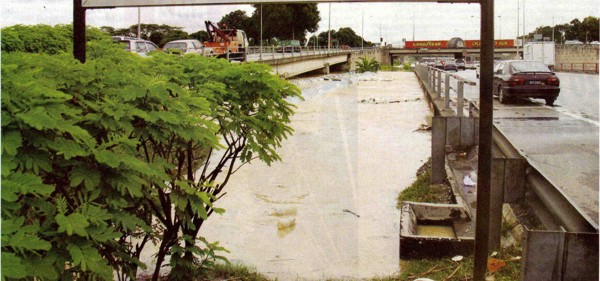
DASAR CETEK: Sungai Damansara melimpah menyebabkan Lebuhraya Persekutuan dinaiki air ketika hujan lebat di sekitar Shah Alam.
