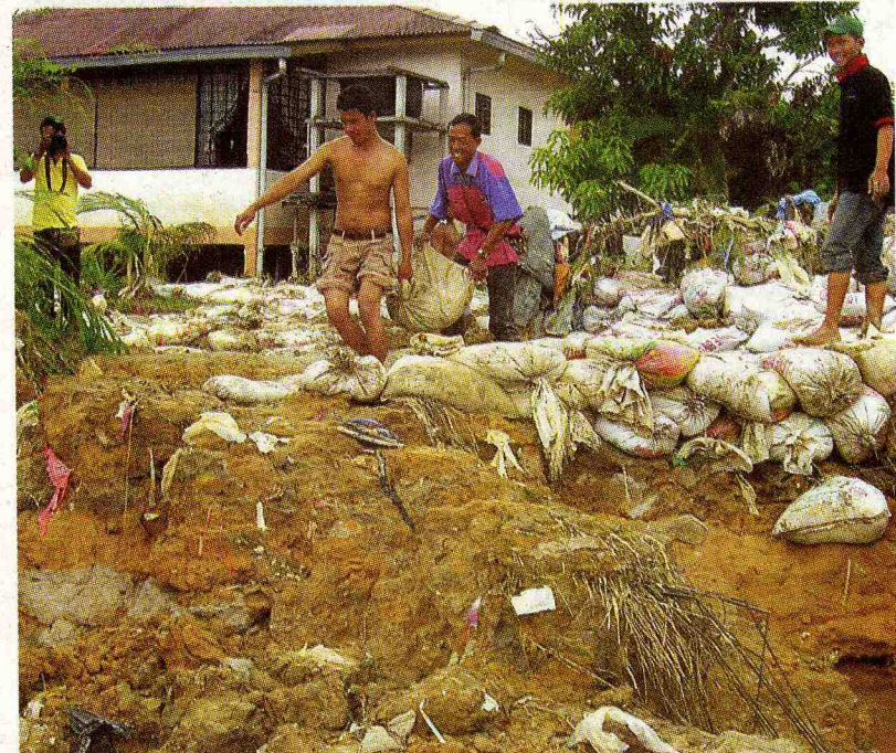
KERJA KERAS: Dua pekerja mengangkat guni pasir bagi memperbaiki benteng Sungai Damansara yang pecah berikutan hujan lebat.
