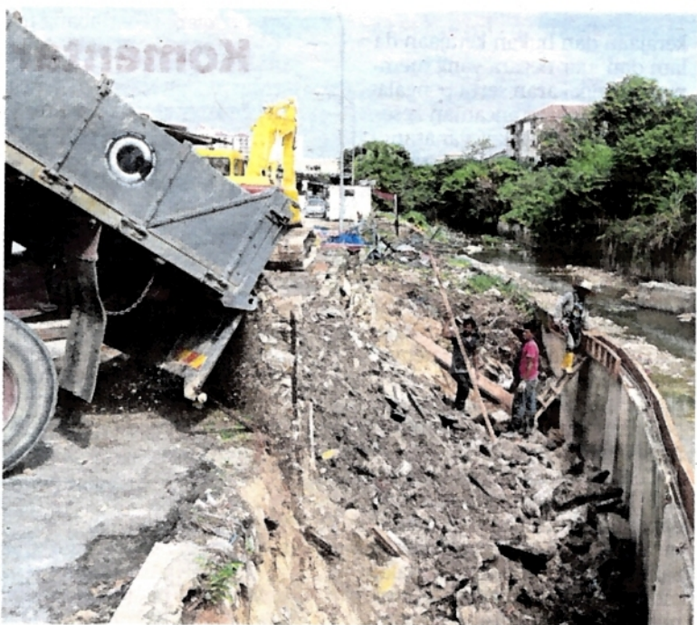
Tebing sungai terhakis ditambak bagi mengelak hakisan lebih teruk.
