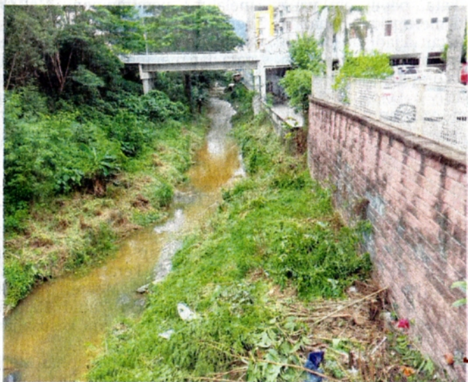
SEMAK samun sepanjang Sungai Jinjang berdekatan One Selayang dan 162 Residency, Selayang telah dibersihkan JPS Daerah Gombak .
