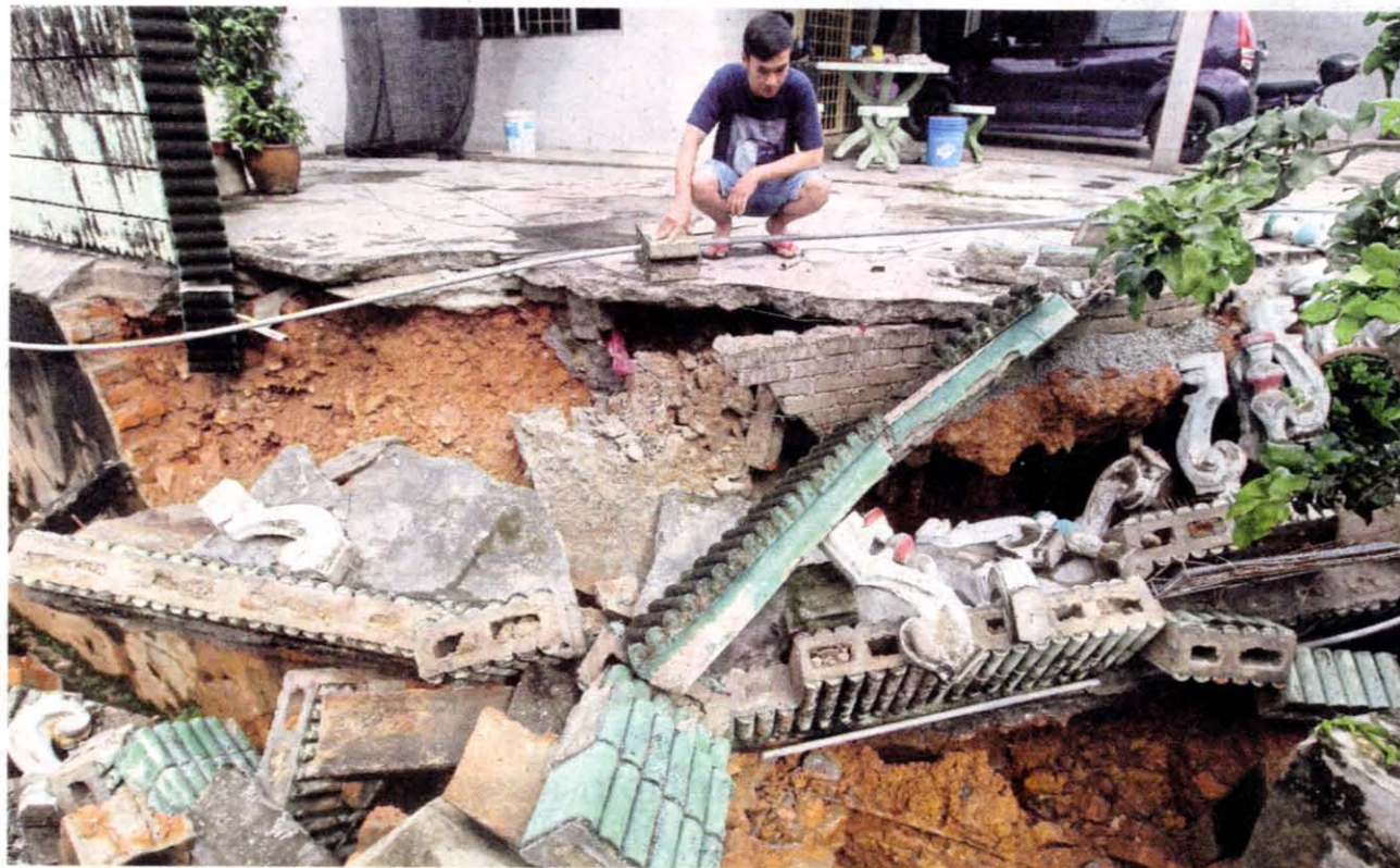
TERM melihat keadaan tembok rumahnya yang roboh dan terjejas teruk akibat tanah mendap di Taman Bukit Kajang Baru, Kajang.
