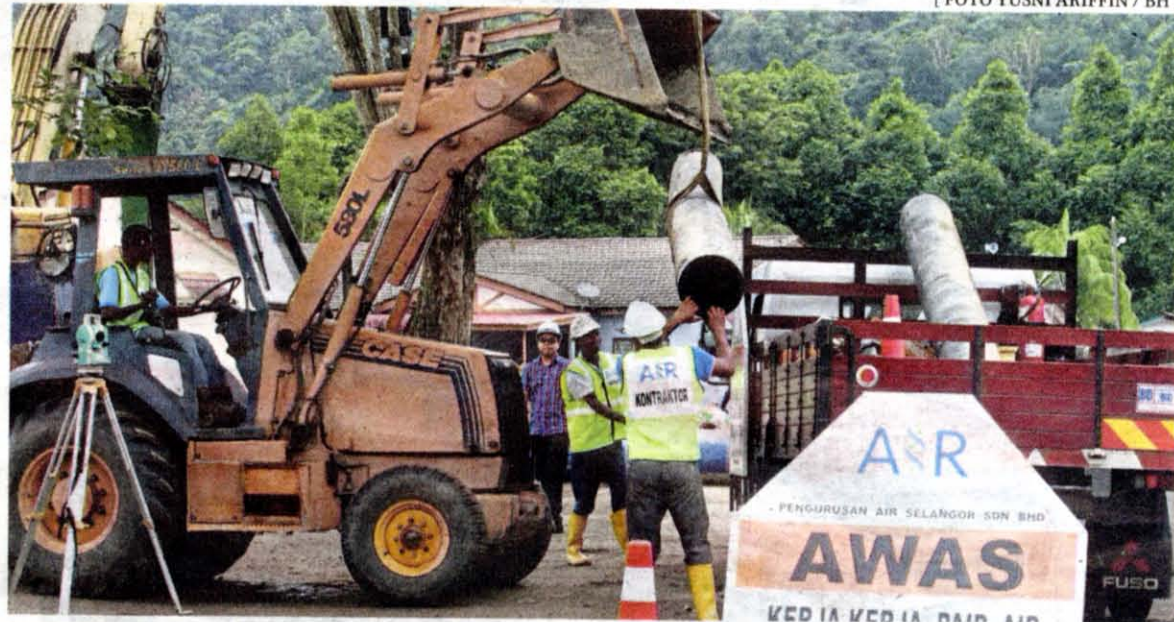
Kerja-kerja penyambungan semula paip air giat dijalankan oleh pekerja kontraktor Pengurusan Air Selangor Sdn Bhd di kawasan tanah runtuh Taman Idaman, Serendah, semalam.
