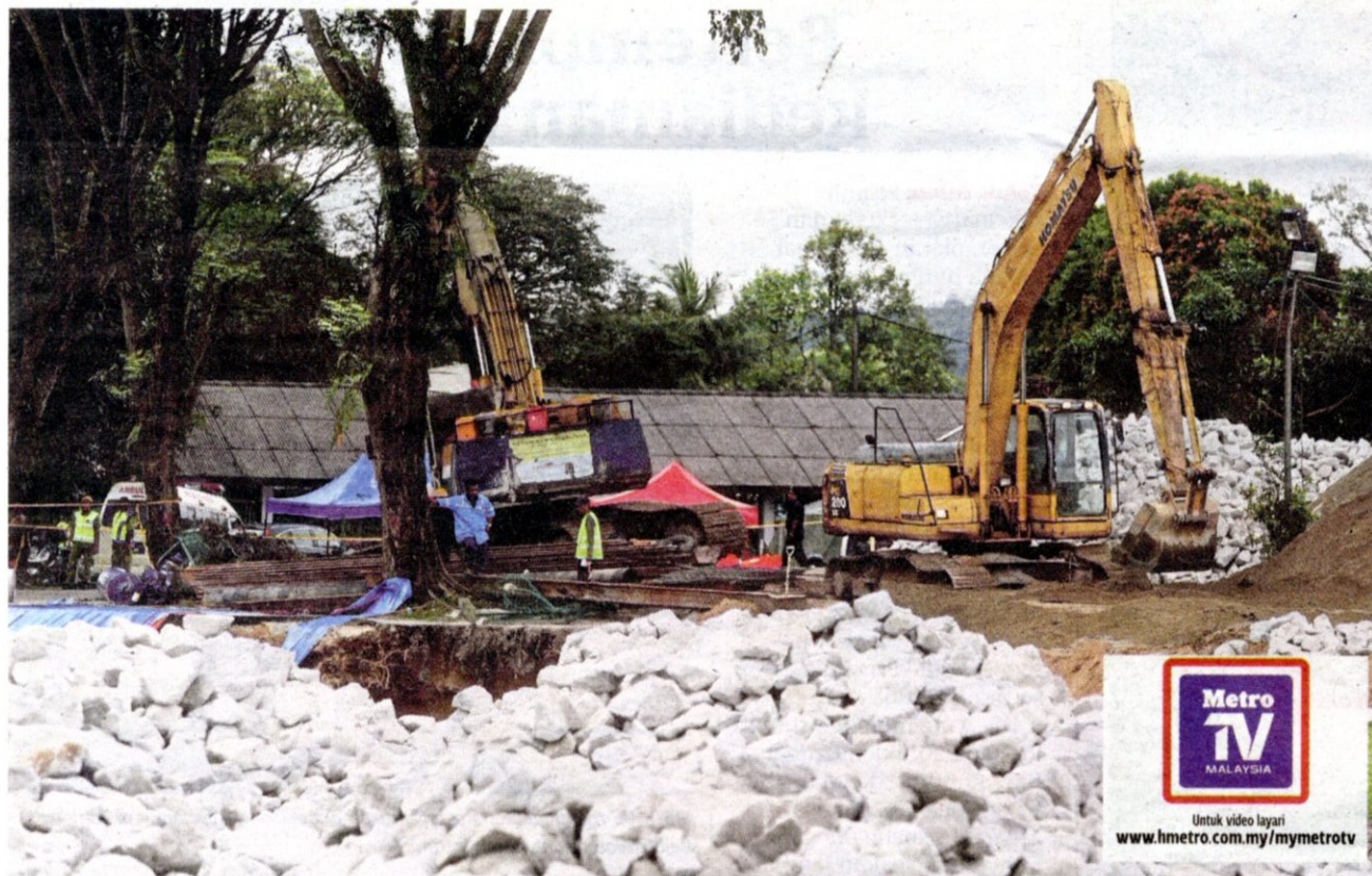
KERJA penambakan benteng dilakukan di lokasi tanah runtuh.
