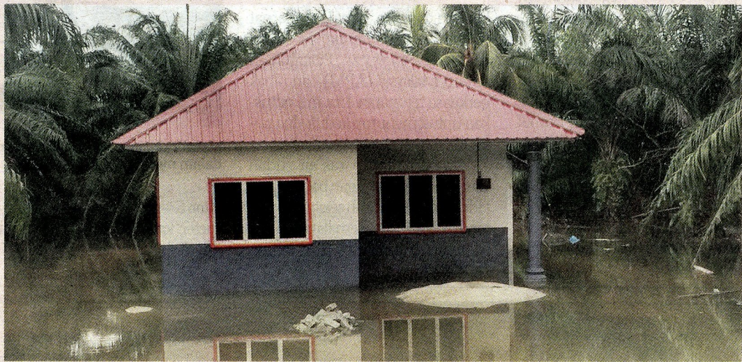
Rumah penduduk ditenggelami air, semalam.
