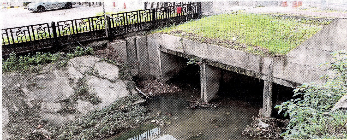
Sistem pembetulan kekotak tiga sel longkang berhadapan Pusat Perniagaan IOI Mall Puchong dikatakan punca banjir kilat.
